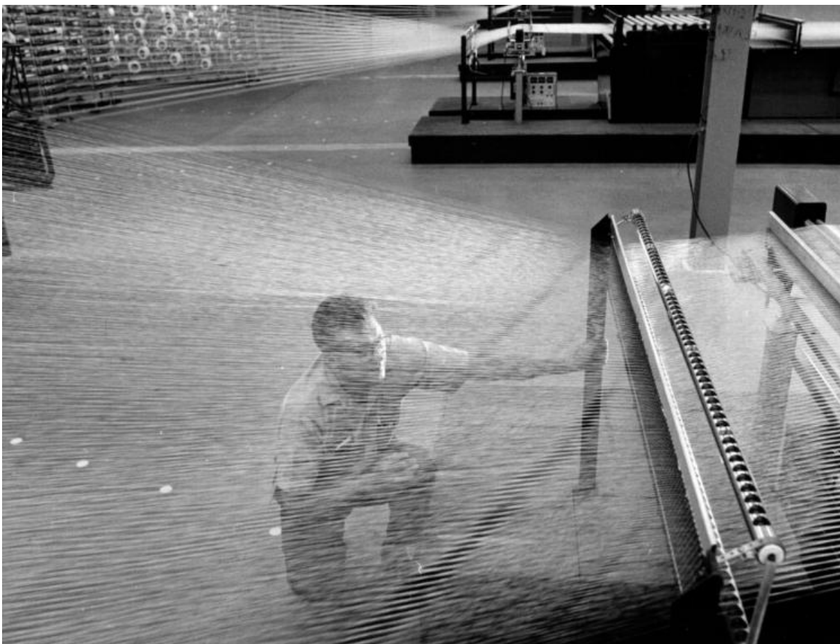
شکل ۱-۱۰- عکس مربوط به سال ۱۹۴۰، مردی در حال کار با ماشین چله پیچی در کارخانه تولید نخ نایلون دوپونت [۲۰]
